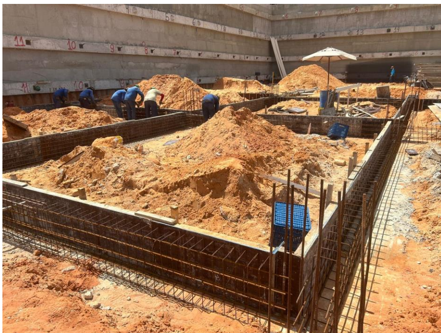
Figura 6. Montagem da forma de vigas baldrames.
