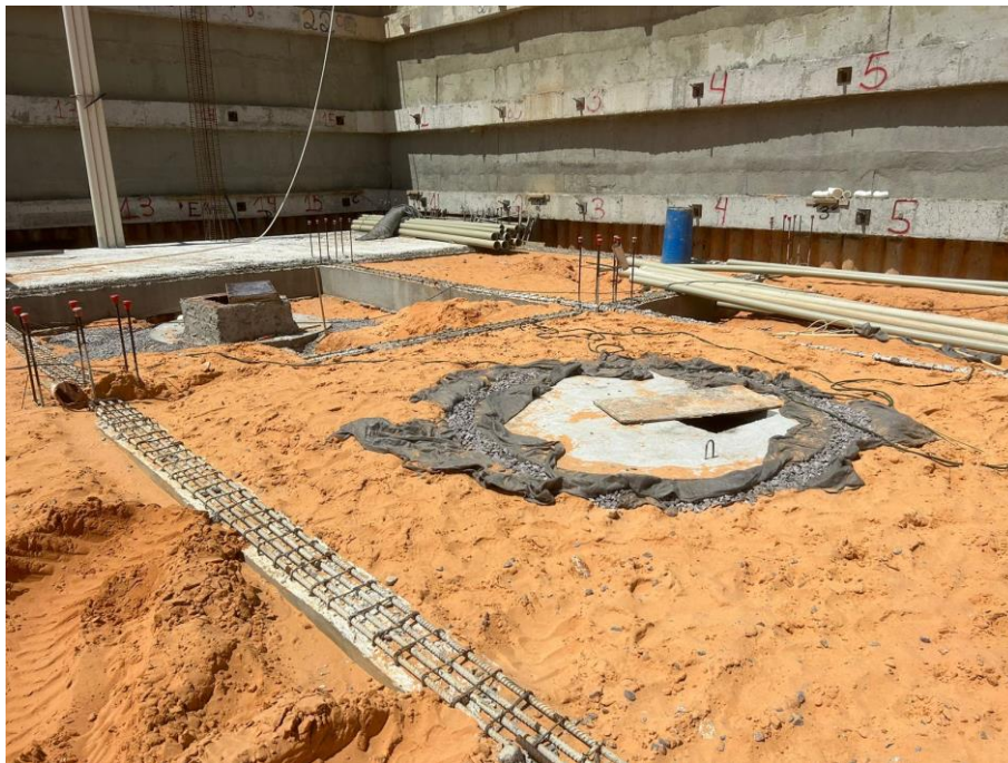
Figura 9. Poços de infiltração executados e vigas baldrame concretadas.
