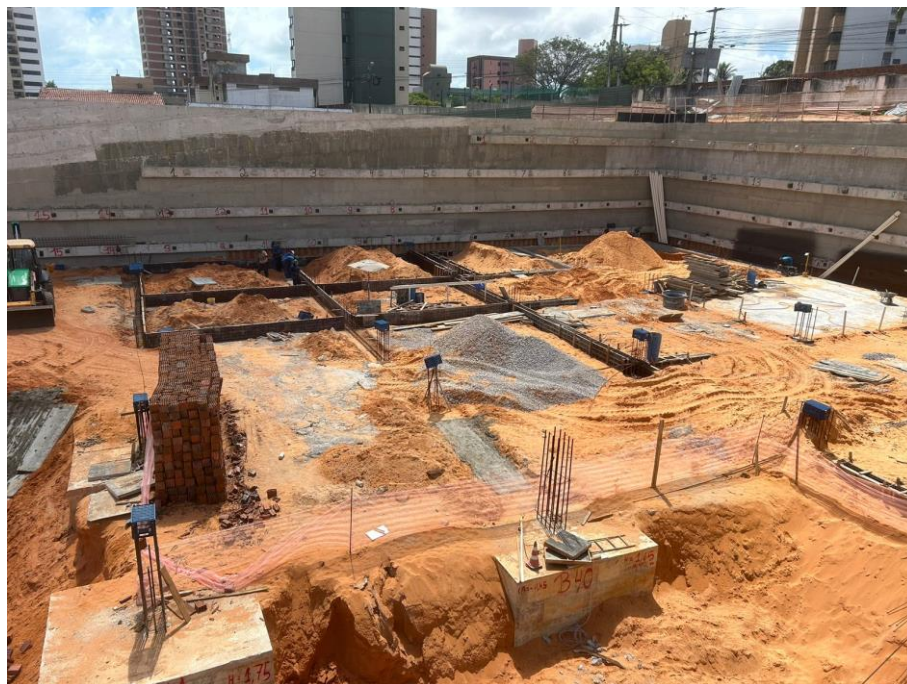
Figura 1. Visão geral da obra.
