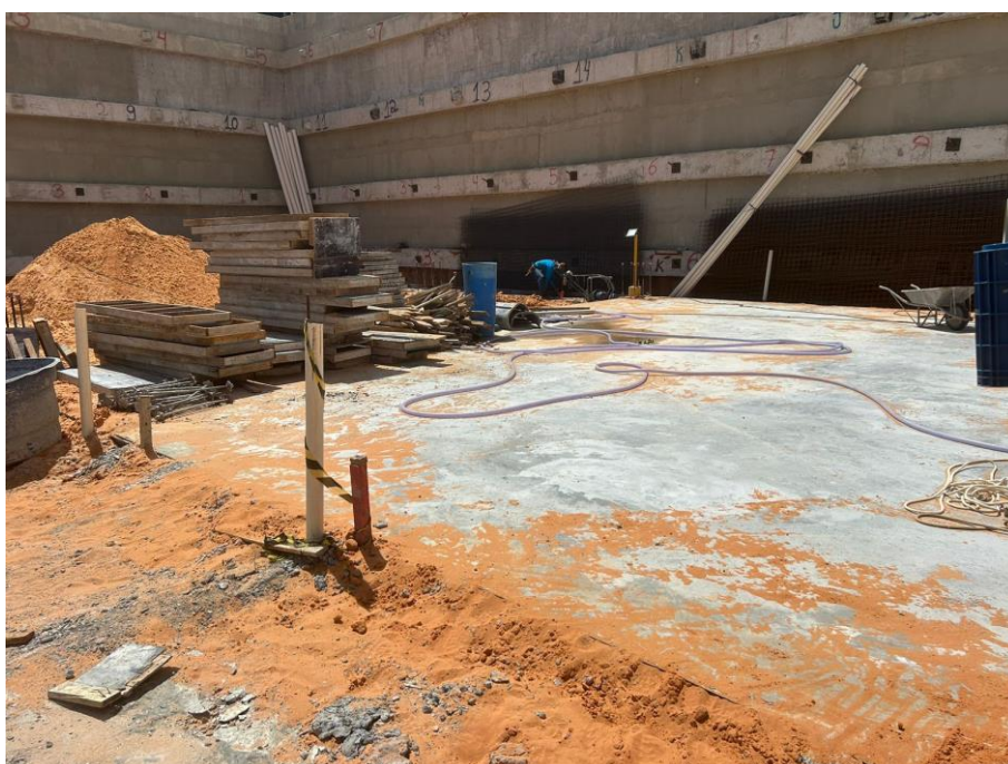
Figura 8. Lajes de piso L54 e L55.
