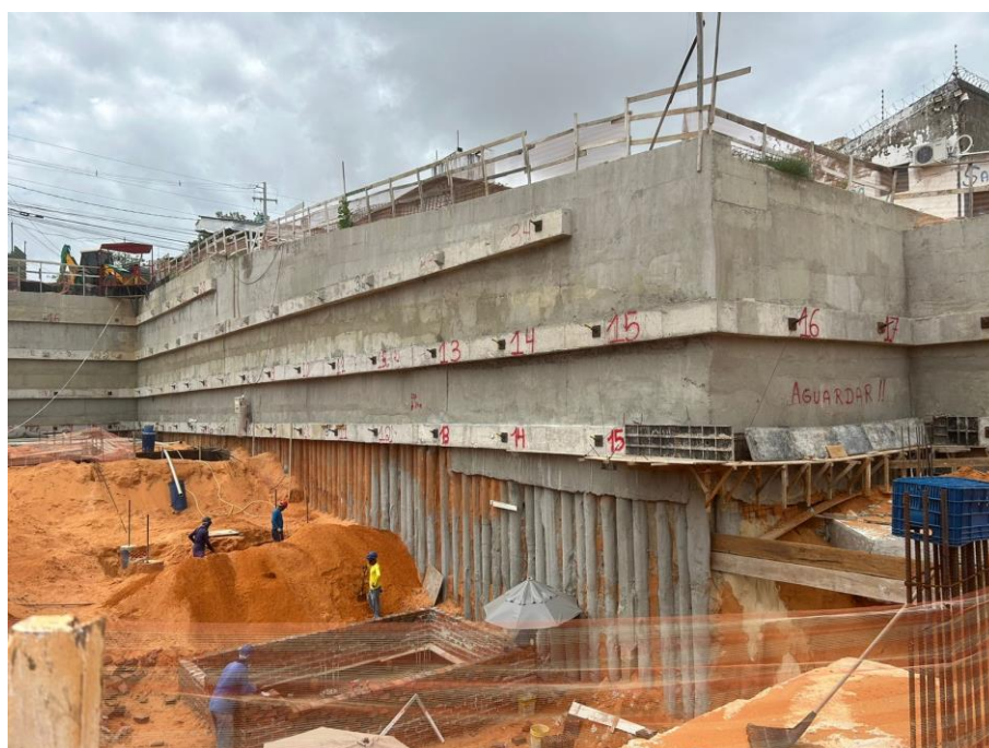
Figura 3. Tirantes do trecho 1D e 1E.
